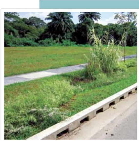
La végétalisation des abords de la ligne BRT avec un système de récupération des eaux de pluie permet de ralentir les eaux de pluie lors d'épisodes climatiques extrêmes afin de protéger le réseau et les quartiers.
