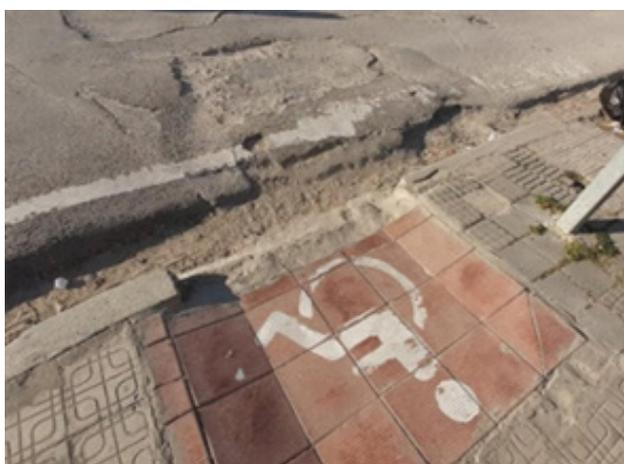
Passage pour handicapés non conforme aux normes et non fonctionnel
