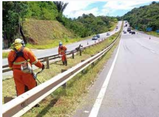
Figure 17 : réseau autoroutier BA-093 de Bahia, Brésil (aujourd'hui)
